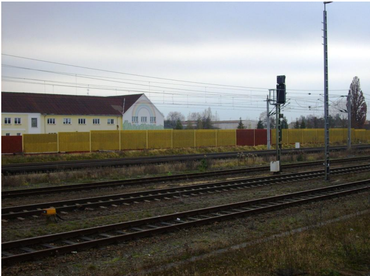
Bild 1: Schalldämmwand bestehend aus mineralisch gebundenen Schallelementen mit nachwachsenden Rohstoffen aus Hanf / Miscanthus (Referenzobjekt Gardelegen)
